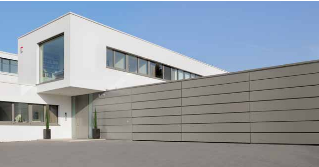
Bauseitige Beplankung mit Aluminium-Verbundplatten
